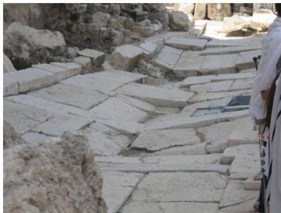
上圖 遭擠壓破壞的路面
